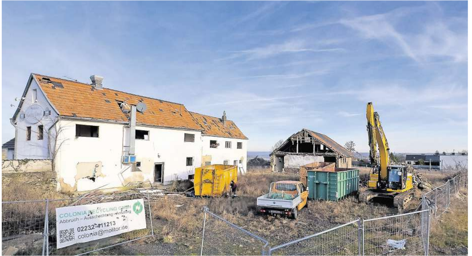
Das schwere Gerät ist bereits da: Die Abrissarbeiten am Hobshof in Vinxel gehen weiter.
